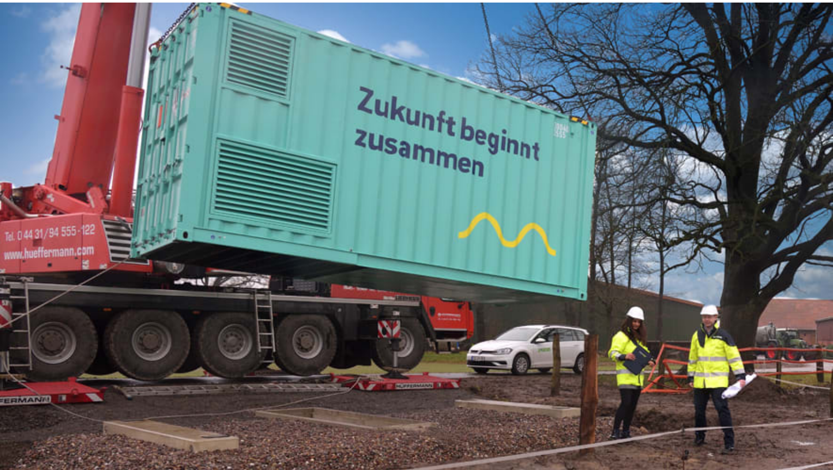
Anlieferung des Batteriespeichers in Abbenhausen
